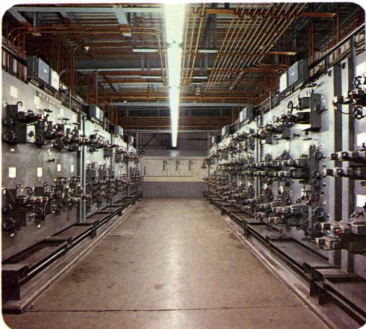
Вид на стойку управления с клапанами для арматуры каупера и доменной печи
