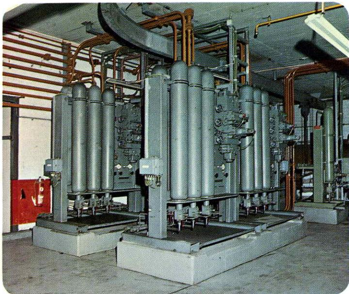
Аккумуляторная установка для снабжения установок каупера и доменной печи
